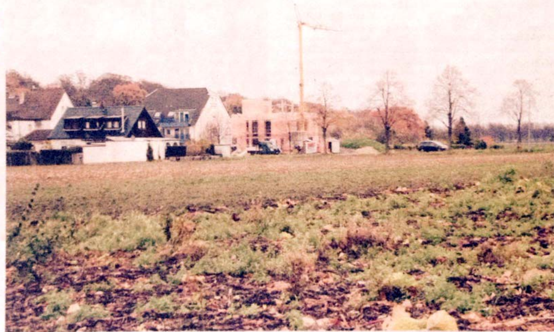
Auf dem Feldstreifen, der sich entlang des Tanzsportzentrums von der Bonnstraße bis zur Linie 18 erstreckt, soll gebaut werden. Foto: Havlicek
